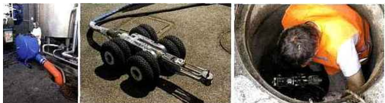
Societe Orea (services de réhabilitation des canalisations sans tranchées).
